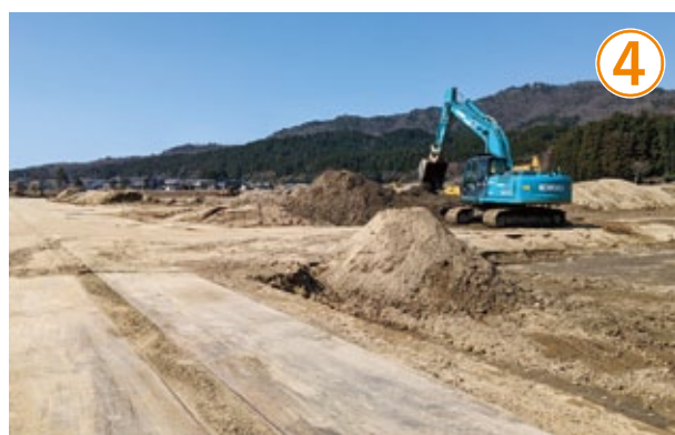
復旧作業の様子
