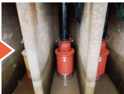
竣工(神林第2-3号揚水機場)
