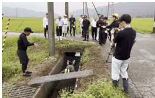
試験施工会の様子
